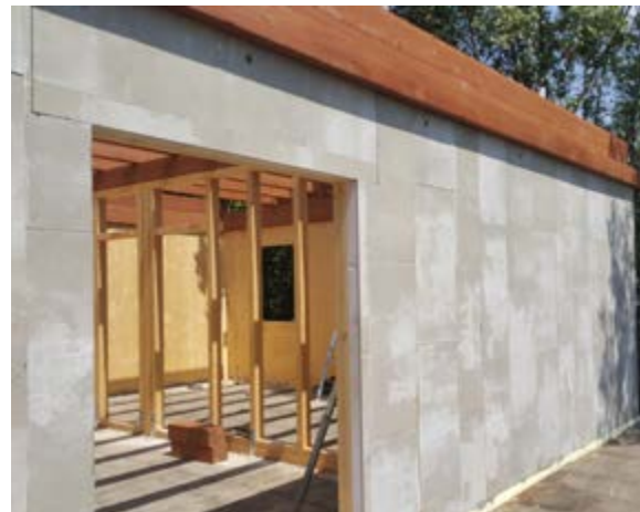
Il sistema di pareti e contropareti in cementolegno BetonWood® N su struttura in legno è raccomandato sia nelle nuove costruzioni che nelle ristrutturazioni.
